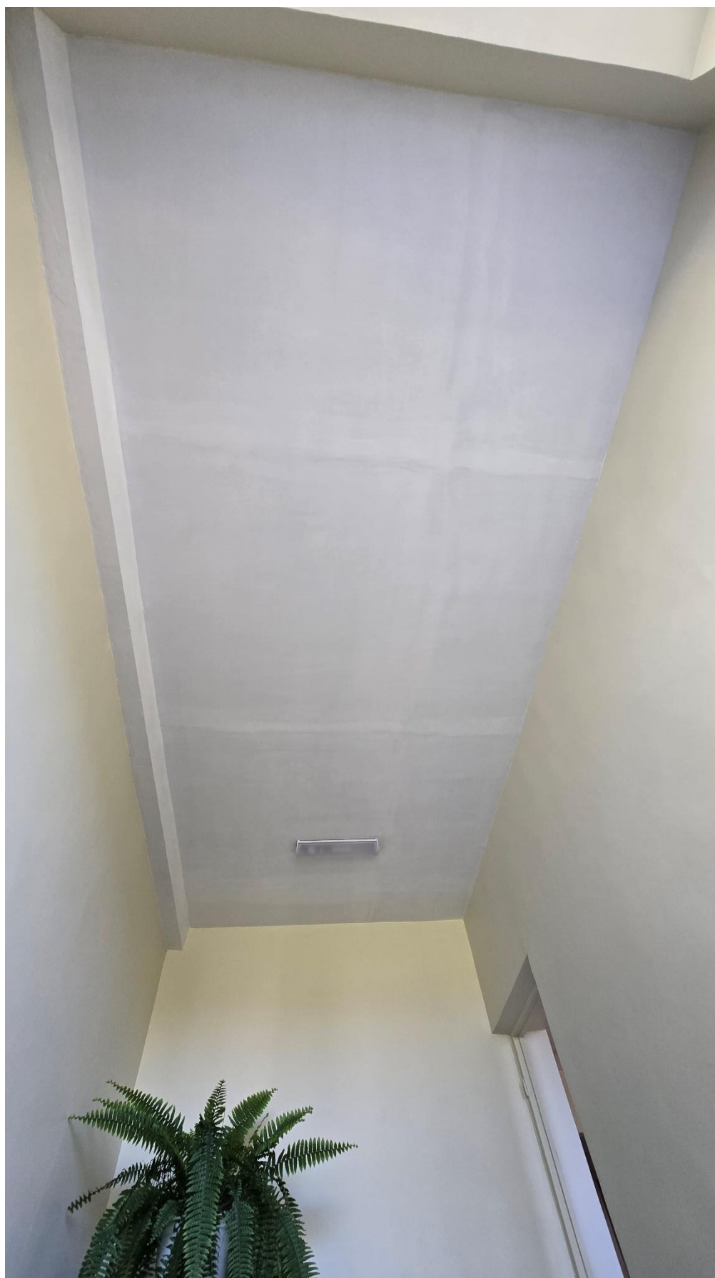
Nuotrauka Nr. 4 Administracinės statinio dalies denginio konstrukcijų bendras vaizdas
